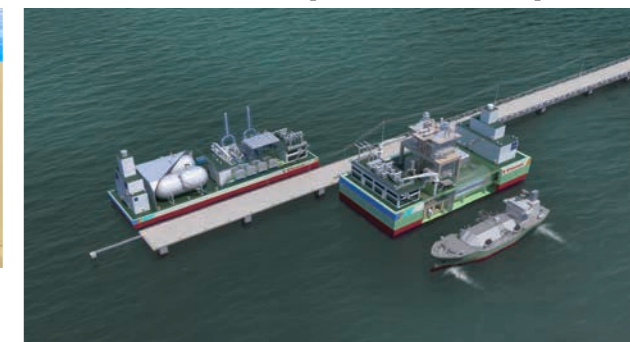
Image of Kawasaki LNG Floating Power Plant.
