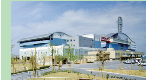
Kishiwada Kaizuka Clean Center Capacidade Diária de Incineração: 531t (177t x 3 fornos) Capacidade de Geração: 12,000 kW Data de Conclusão: Março de 2007
