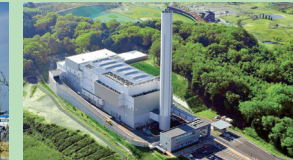
Hirakata Tobu Waste Incineration Plant Capacidade Diária de Incineração: 240t (120t x 2 fornos) Capacidade de Geração: 4,500 kW Data de Conclusão: Dezembro de 2008
